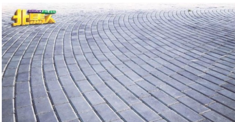
就算是停车场的道路路面，也考虑到环保而辅以“可呼吸”的透水混凝土砖块。
