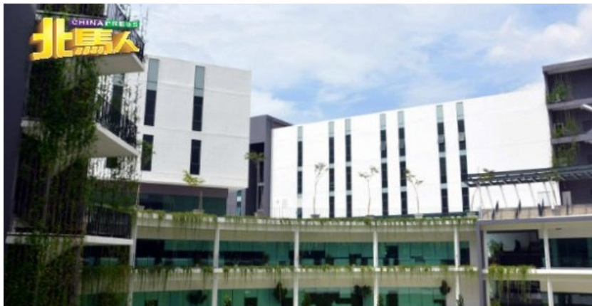
伟特建筑物建以落地玻璃窗，以便自然采光，外面种植各类攀缘性或茎蔓性植物如碟豆花等，形成一道植物绿墙，让建筑物保持绿意凉爽。
