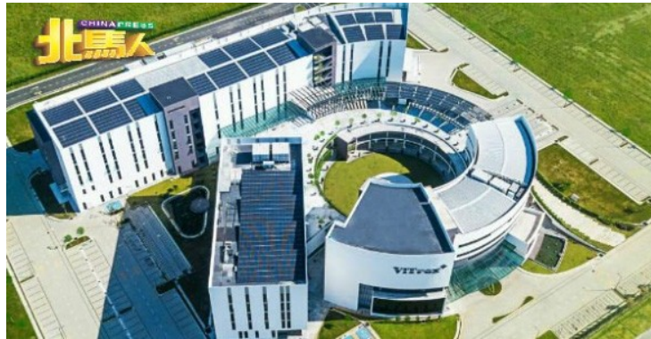
伟特科技外观如眼睛，采用30%绿色环保材质的建筑原料，屋顶设有1410块太阳能板，采用太阳能发电，被咸省市议会颁以“绿色建筑指数”证书。
